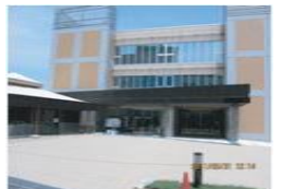
外壁・外部通路清掃
